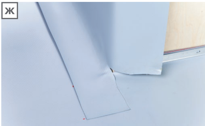
Ж. Затем провариваются вертикальные соединения мембран.
