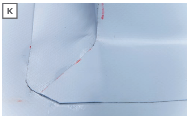
К. Полностью изолированный внешний угол плоской кровли.
