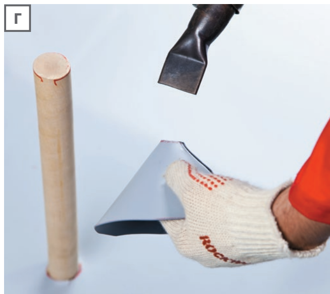
Г. Разогреваются внутренняя и внешняя кромки конуса.
