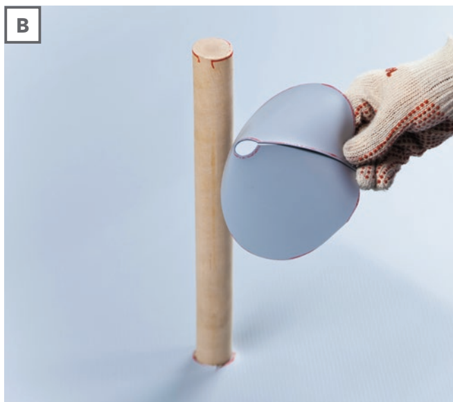
В. И сваривается конус с отверстием в вершине. Диаметр отверстия должен быть меньше диаметра изолируемого прохода.
